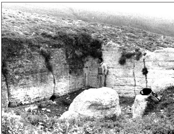
Fig. 11: Vestiges du bassin d'Asefdar construit en pisé, (© Belatik M).
