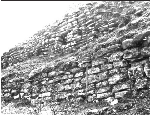
Fig. 12: Vestiges d'un mur en terrasse de la Qal'a Sharfa, (© Belatik M).
