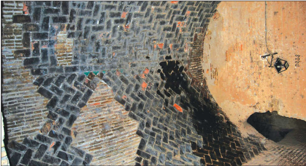
Fig. 29: Bâb al-Qaşba, détail de la construction de la voûte du deuxième vestibule d'entrée, (© Kafas,1991).
