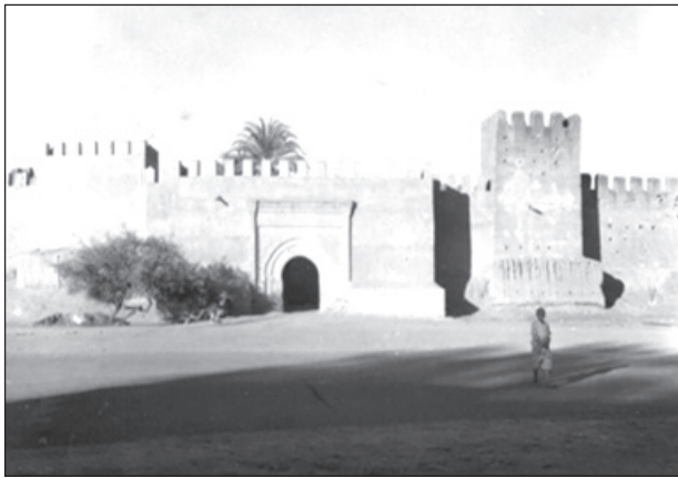
Fig. 26: Bāb al-Qaṣba, après sa restauration vers le milieu du XX ème siècle, la structure surmontant la porte a complètement disparue, (Archives DPC).
