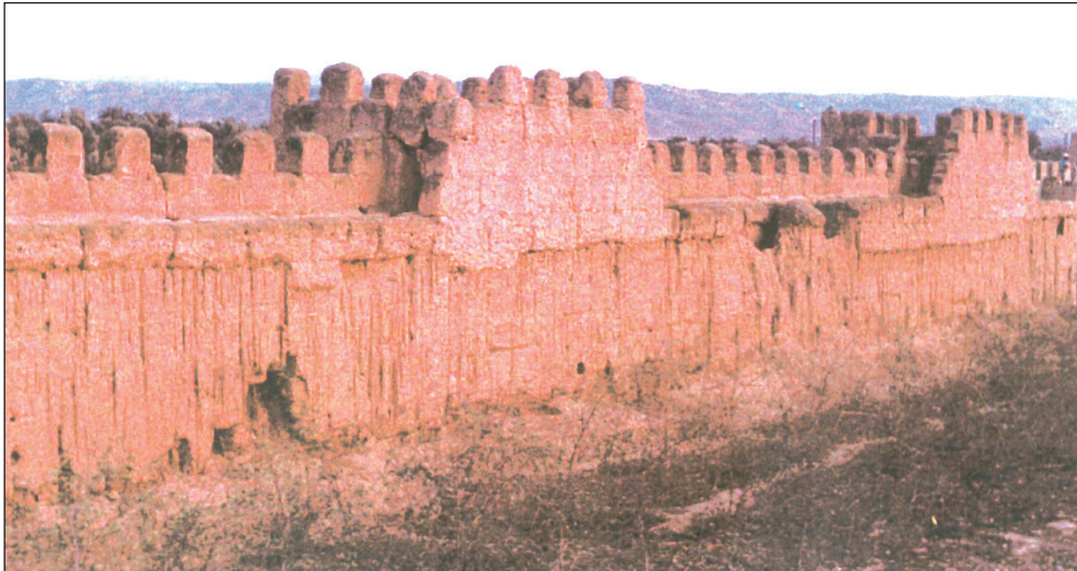
Fig. 33: La grande muraille, reprise de maçonnerie ancienne, (© Acroterre-1999).
