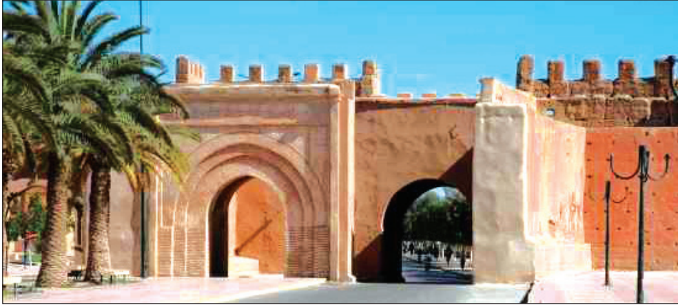
Fig. 13: Bāb al-Sansla, vue la façade intérieure après démolition de la tour sud de la porte, (© Kafas, 2013).
