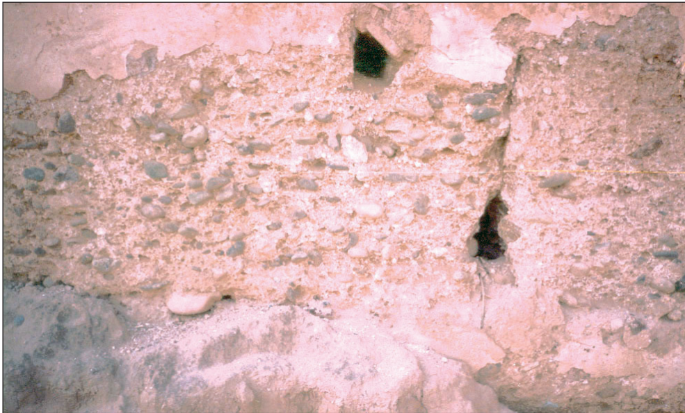
Fig. 34: Banchée de pisé reposant directement sur le sol, côté Nord de la muraille, (© Kafas, 1991).
