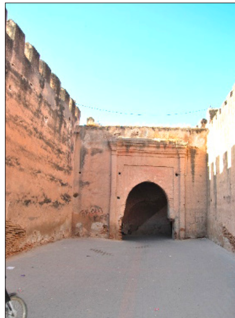
Fig. 28: Bāb al-Qaṣba, vue du deuxième passage voûté, (© Kafas, 2013).
