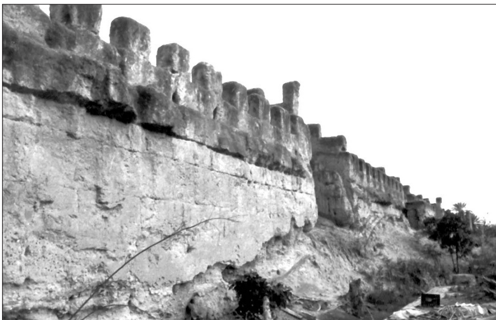
Fig. 9: Côté oriental, remarquer la grande butte de terre au pied de la muraille correspondant à l'effondrement du chemin de ronde. La muraille semble s'agencer en pente, les fondations n'en sont pas évidentes malgré les importants arasements à son pied, (© Kafas, 1999).
