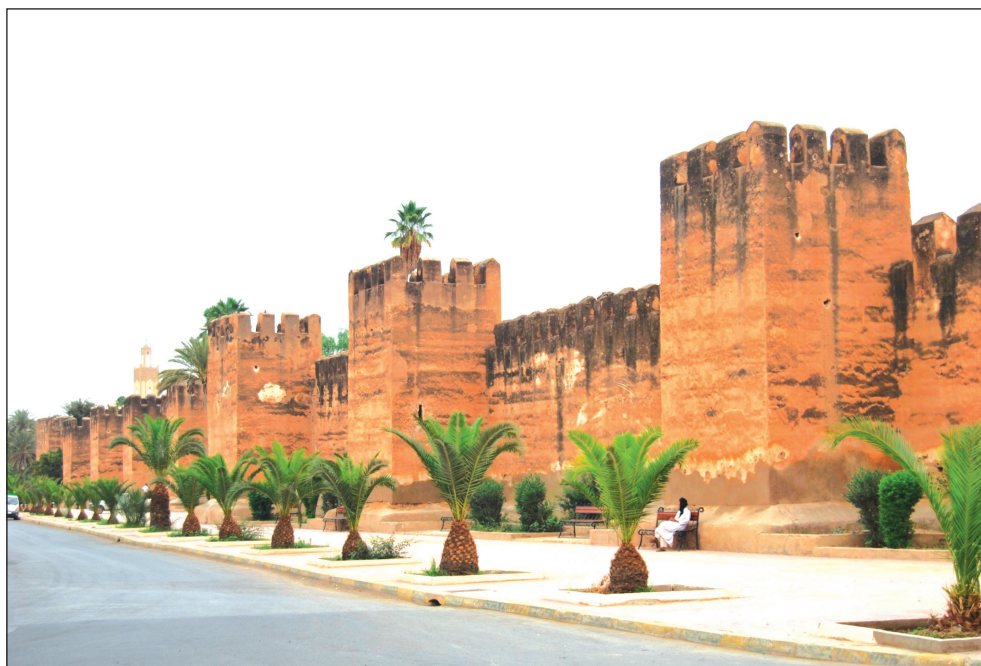
Fig. 22: Qasba, détail d'une tour et courtine. L'enduit qui en couvre la surface est de couleur ocre et fut appliquée lors d'une des récentes opérations de restauration, (© Kafas, 1991).
