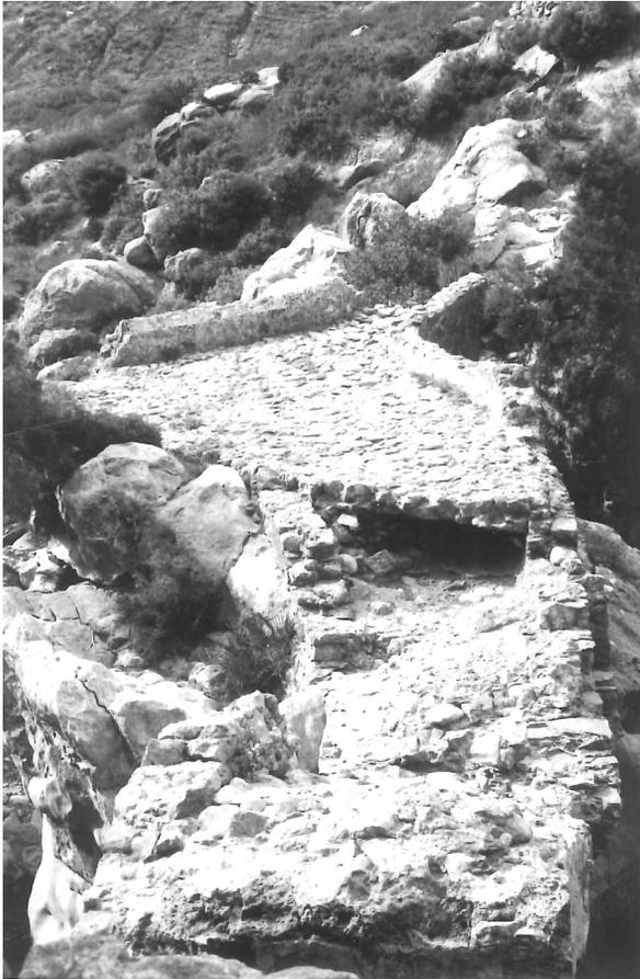
**Fig. 10:** Pont aval sur l'oued Talambot. État du tablier en 1982. Voir figure 2 (© P. Cressier).
