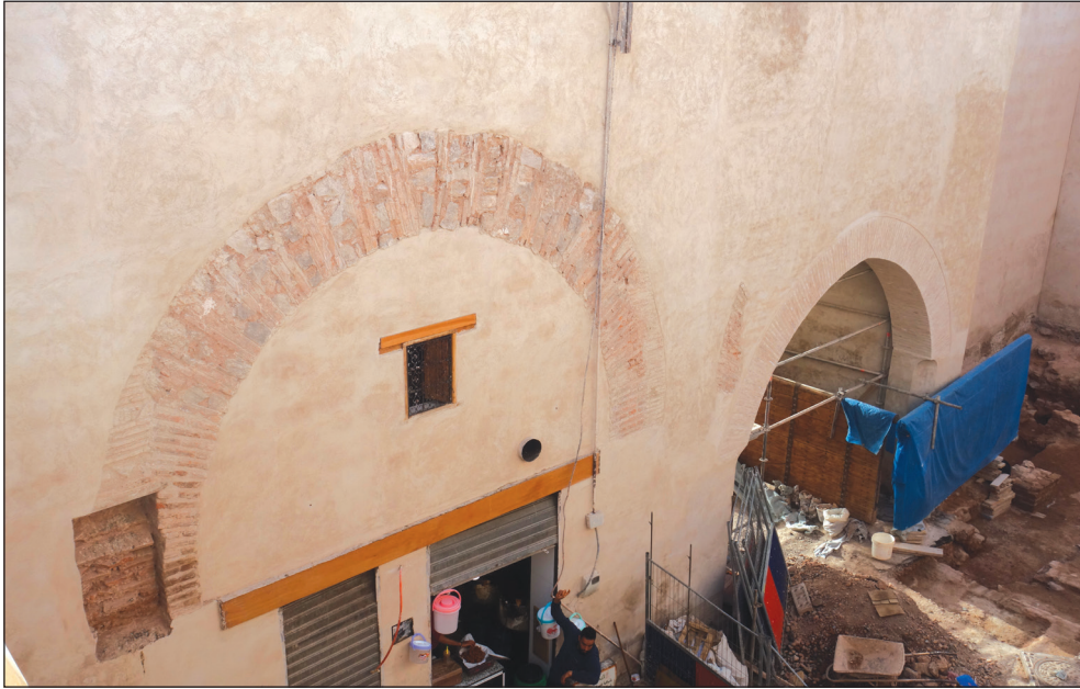
Fig. 13: Vue d'ensemble de la façade intérieure de Bab Agnāw présentant l'arc alaouite au-dessus duquel ce qui reste de l'arc almohade [Mission Agnaou 20-21].
