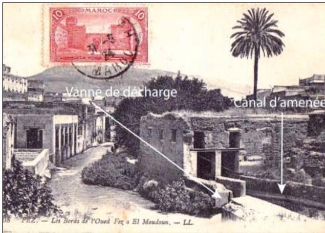
**Fig. 34:** Nouvelle configuration du bâtiment rectangulaire (moulin) après démolition du bassin de retenue et changement du dispositif d'aménée d'eau (Ancienne carte postale).
