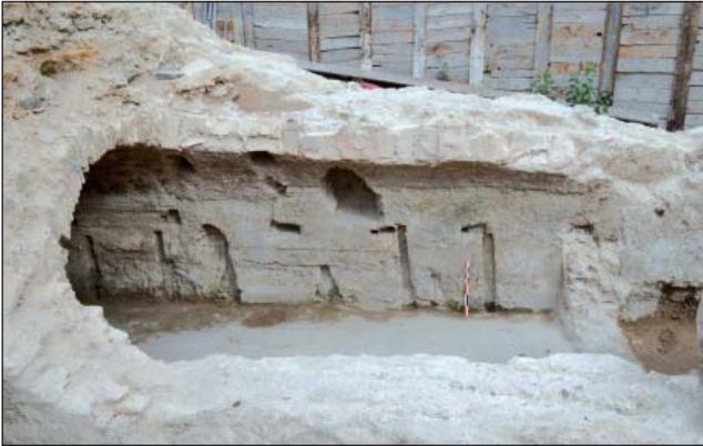
**Fig. 7:** Parement interne de la galerie est, avec détails des saignées de fixation de l'ossature de cuvelage en bois (Cliché des auteurs).
