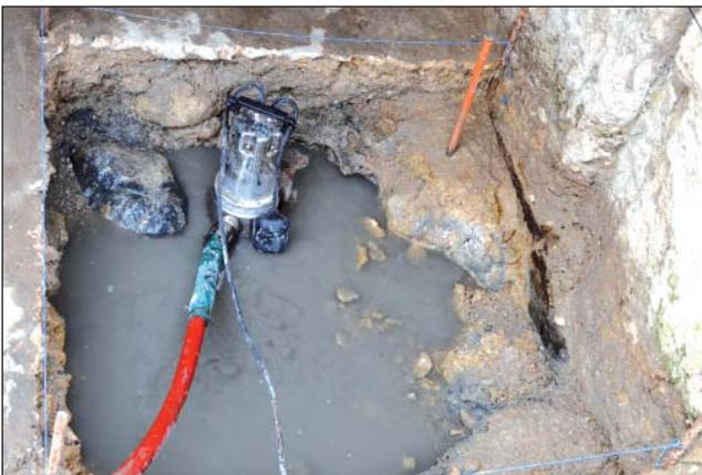
**Fig. 41:** Pompage des remontées d'eau dans le sondage (Cliché des auteurs).
