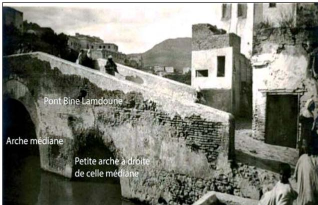
**Fig. 32:** Arches permettant le passage de l'eau en direction du moulin (Ancienne carte postale).
