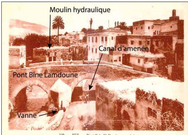
**Fig. 29:** Dispositif destiné à acheminer l'eau du pont Bine Lamdoun vers le moulin hydraulique (Ancienne carte postale).
