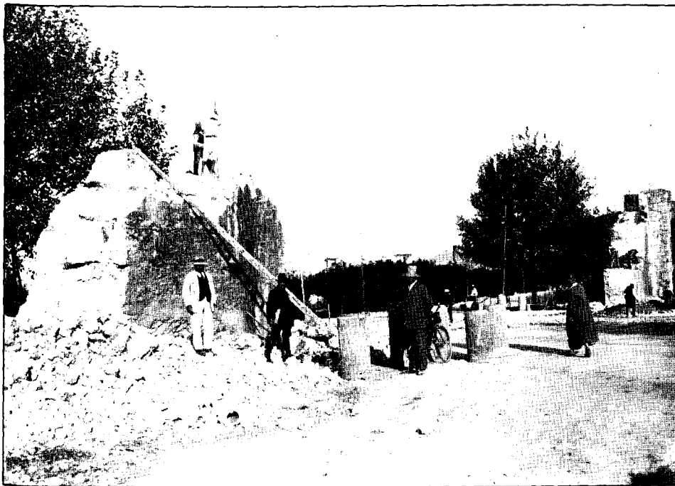
Photo N° 19 - Démolition de l'aqueduc Ain el Oméir près de l'entrée de la place du Commerce, afin de dégager le passage. La canalisation passe sous la route en siphon. vers 1916
