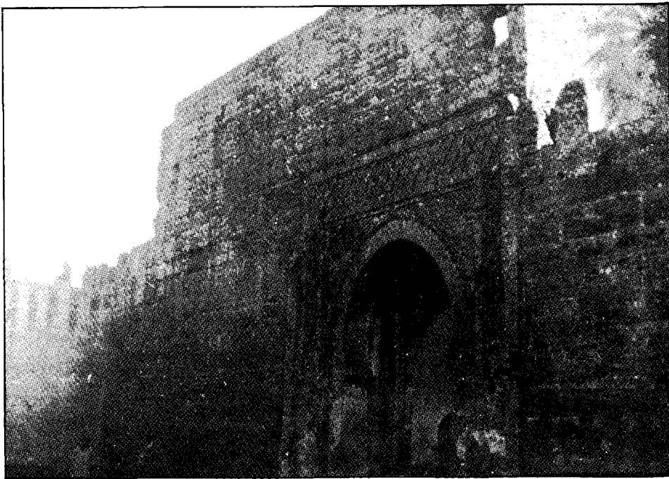
Photo N°8 - Bab Agdal. Vue de la façade ouest (enceinte intérieure) prise de la porte de l'enceinte extérieure.
