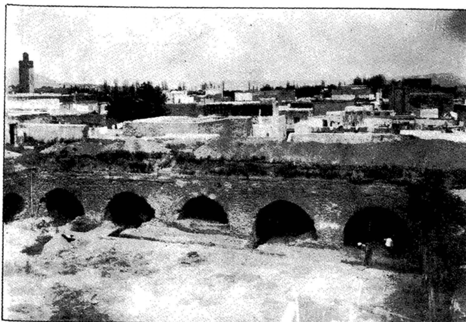
Photo N°6 - Vue de l'intérieur de Dar Baroud, dans le quartier de Fès-Jdid. (démoli en 1938) A gauche, le minaret de la mosquée Lalla Ghriba
