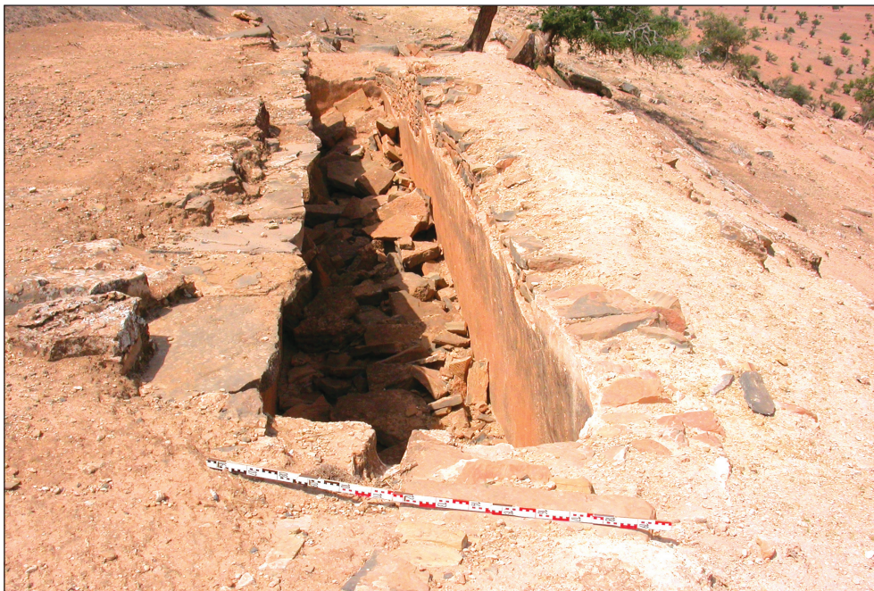
Fig. 2: Assif n-Warghen, Anti-Atlas. Vue d’une citerne d’époque moderne ou subactuelle, (© Mission archéologique à Igiliz).
