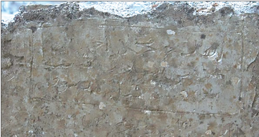
Fig. 1: Pont ancien sur l'oued Farda. Inscription incisée dans l'enduit encore frais, (© Antonio Casado Puerto).
