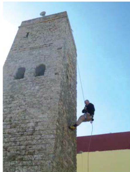
prélèvements de mortier
